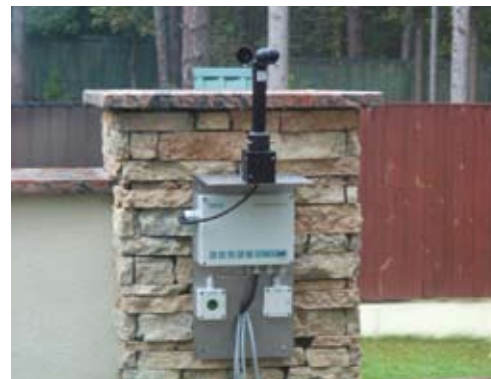
Погодная станция содержит сумеречный датчик для управления фасадным и ландшафтным светом
