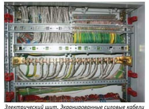
Электрический щит. Экранированные силовые кабели (в металлической оплетке) для диммируемых групп света
