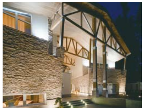
Загородный особняк, внешнее освещение работает по датчику освещенности и таймеру
